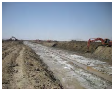
شکل ۱۹- بستر مرکب کانال انحراف زرينه رود.
